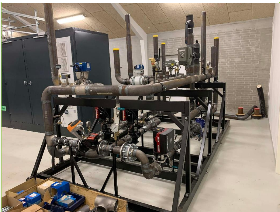
Figur 3 Nordenskov - Veksler unit fra VP til nettet - I hjørnet ses hoveddør ud til Nordenskov by
