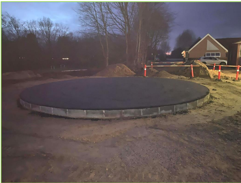
Figur 2 Nordenskov - Fundament til akkumuleringstank
